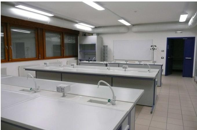
**Le bancate del laboratorio di Chimica, con gli impianti idraulico ed elettrico. A soffitto l'aspirazione, sul fondo, la cappa.**
