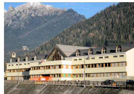
La Sede dell'Istituto di Istruzione Superiore a Transacqua
