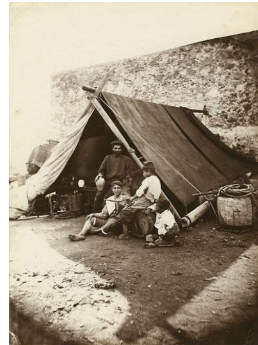
Messina, Sopravvissuti in una tenda di fortuna.
